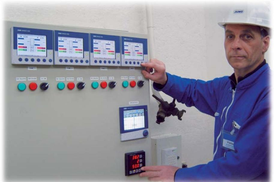
Schaltpult oder Schaltkonsole für Regelung, Archivierung und Alarmübertragung
