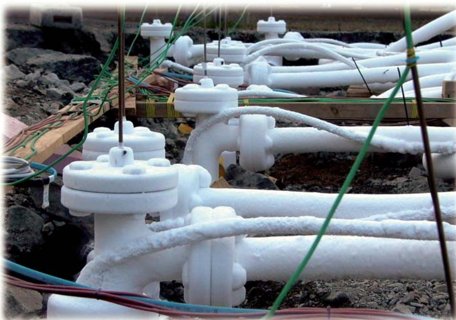
Die Bodenvereisungsanlage in Betrieb
