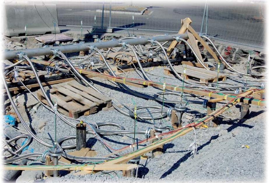
Die Bodenvereisungsanlage im Bau
