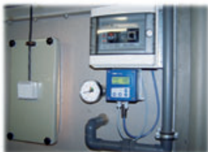
Prozesssteuerung CTI-500 mit abgesetztem Sensor in Wandmontage
