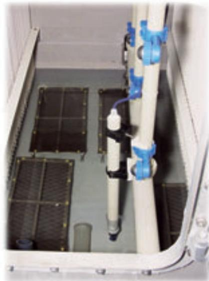
Blick in den Luftwäscher auf den tauchfähigen LF-Sensor und die Reaktionsmatten
