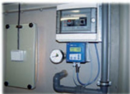
Prozesssteuerung CTI-500 mit abgesetztem Sensor in Wandmontage
